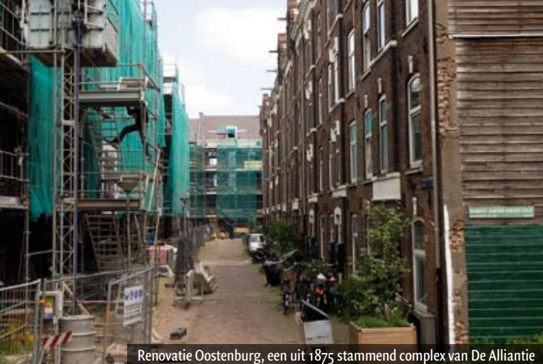
Renovatie Oostenburg, een uit 1875 stammend complex van De Alliantie
