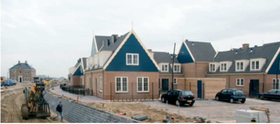
In de nieuwbouw worden MGE-constructies vaker toegepast, zoals hier in Saendelft (zie NUL20, nummer 29)
