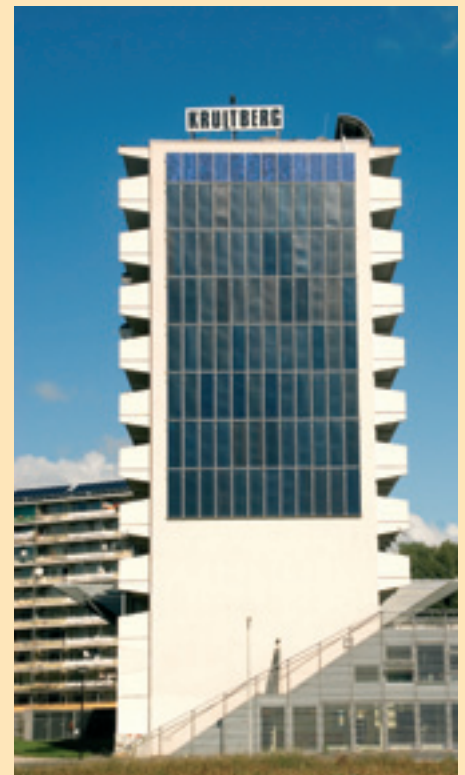
Kruitberg: Behalve op het dak ook zonnepanelen in de kopgevel en de borstweringen.
