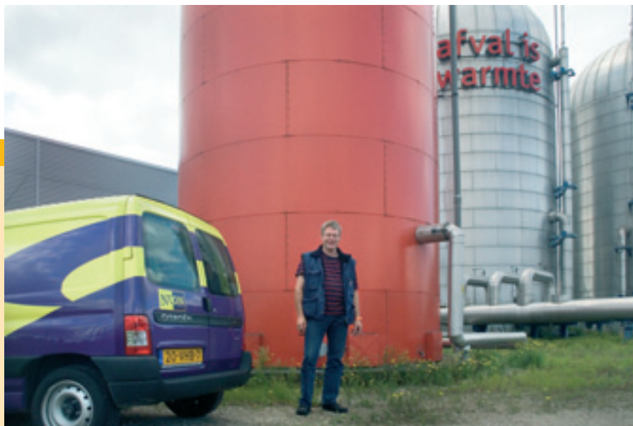
Nuon-medewerker Bert Bijker bij de afvalwarmte-installatie aan de Hemweg
