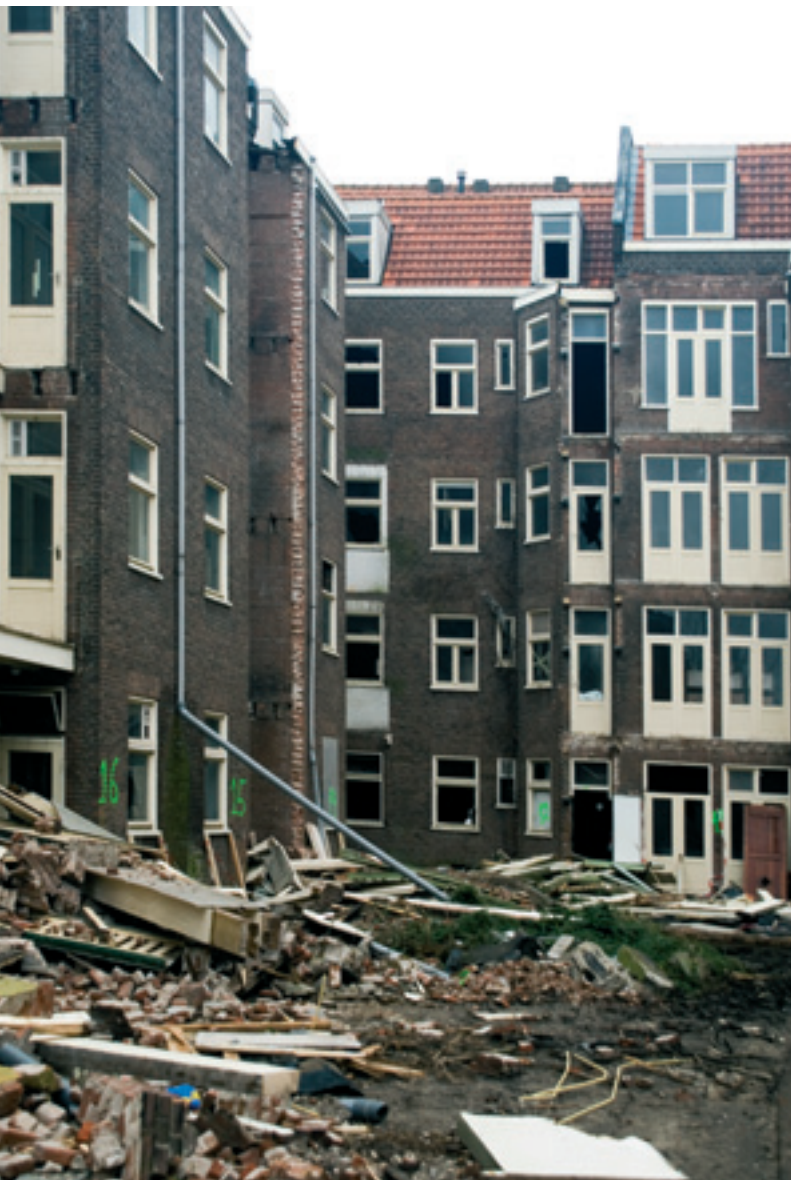
Renovatie van blok Knollendamstraat-Polanenstraat met 173 woningen
