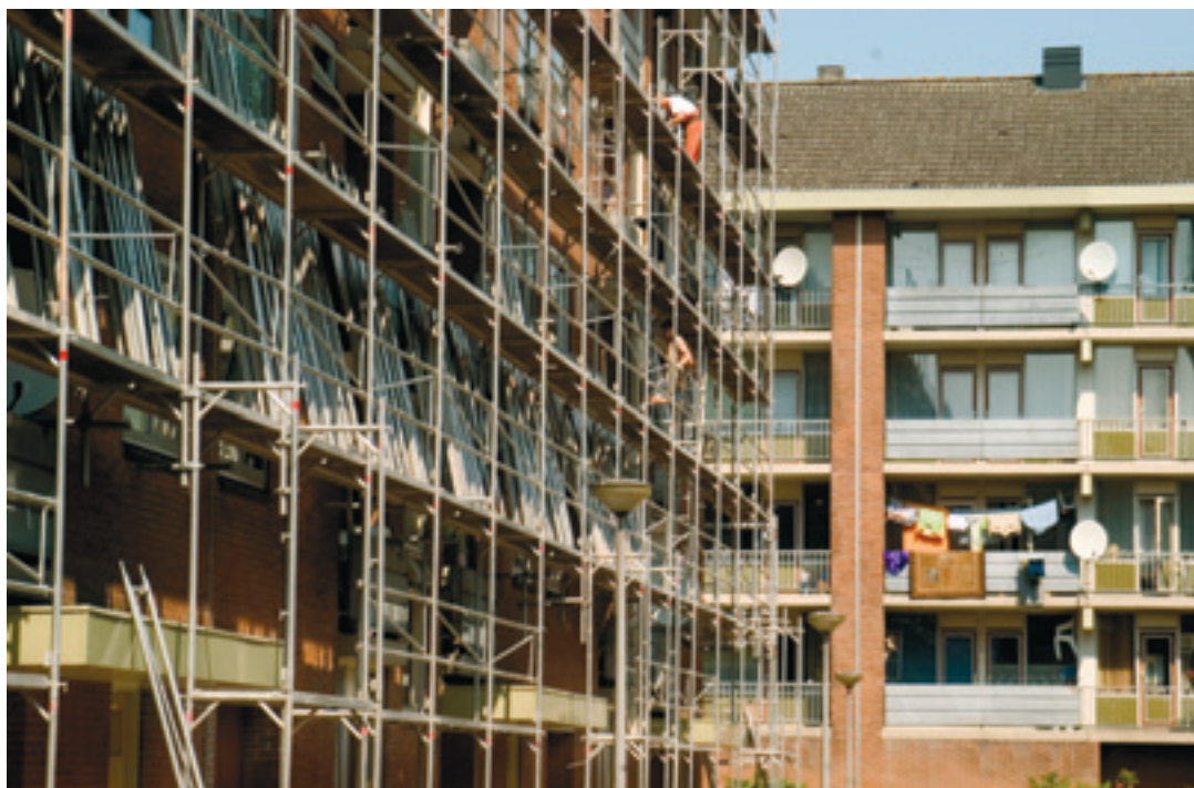
Renovatie in Nieuwendam Noord
