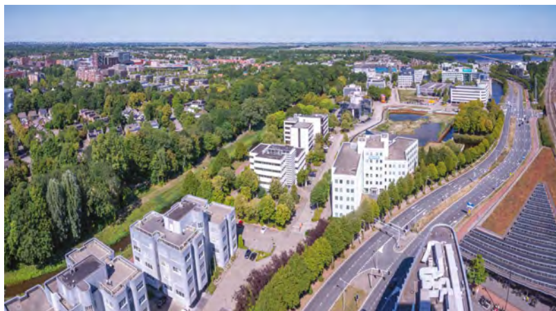
Stationsgebied Hoofddorp met de eerste gebouwen van Hyde Park in aanbouw
