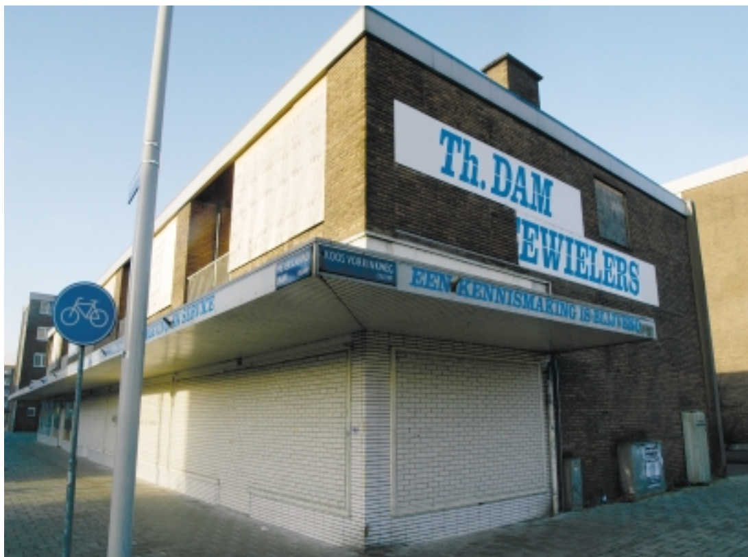
Stadsvernieuwingsgebied in het Zuidwestkwadrant in Osdorp
