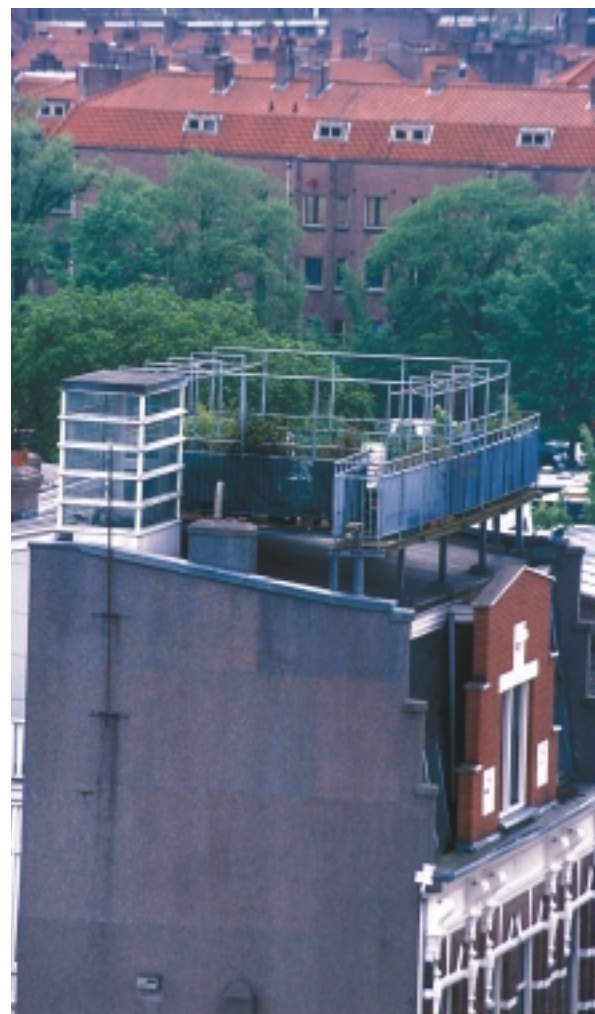
Staalconstructie met daktuin op een pand in de Graaf Florisstraat
