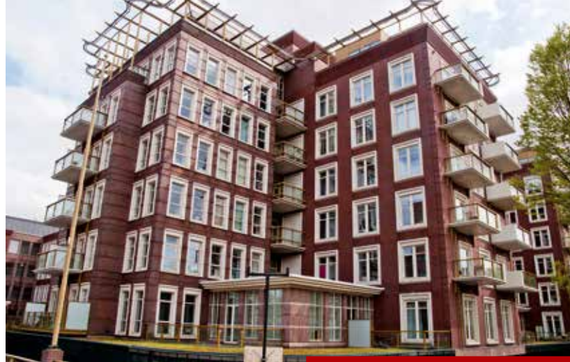
Molenwerf, eens kantoor, nu woongebouw
