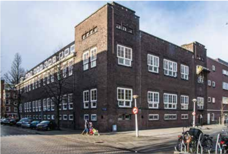
In dit pand aan de Trompenburgstraat tussen de Rijnstraat en de Vechtstraat gaat de Alliantie 35 woningen bouwen. Het Huis van de Wijk blijft er gevestigd als ontmoetingsplek voor alle wijkbewoners.
