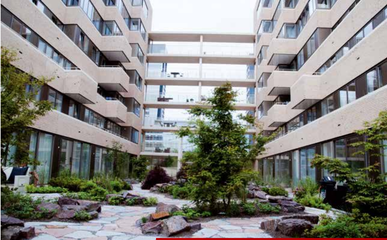
Het woongebouw OPZUID met 46 appartementen werd dit voorjaar opgeleverd
