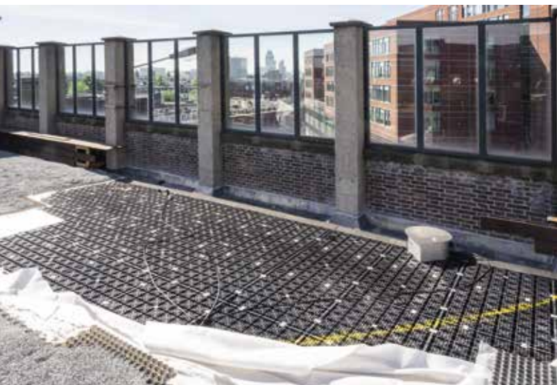
Daktuin in aanleg op het Benno Premselahuis. Begin april werden de eerste plastic kratten van het nieuwe waterbergingsysteem op het dak gelegd.
