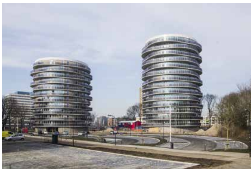
Twister en Tango in Haarlem. Tango was in 2018 het eerste vrijesectorhuurproject van Vesteda in Haarlem. Elk appartement heeft drie kamers en een oppervlakte van ongeveer 90 m 2 . Bij de oplevering werden de woningen aangeboden in het middeldure huursegment.
