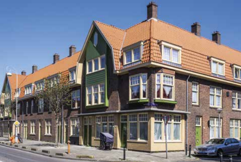
Gentiaanbuurt, Amsterdam Noord. Ymere heeft de woningen bij een renovatie op het warmtenet aangesloten.
