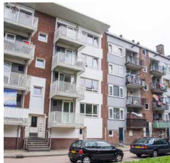
Nul-op-de-meter-renovatie van portiek-etagewoningen in de Wegener Sleswijkbuurt. De opknappbeurt van het rechterdeel is eerder dit jaar stilgelegd na protesten van bewoners. Er waren zowel klachten over de planning als de kwaliteit van de uitvoering.
